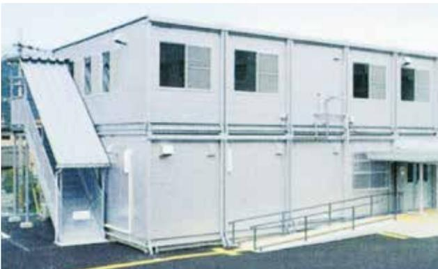
完全工場生産で、建物の内装・照明設備や部材がセットしており、組み立て・解体を繰り返しても廃材が出ず、資源の無駄がありません。現場ではジョイントユニットを使って施工するだけなので、短期間での施工が可能です。また、必要設備をワンタッチで取り付ける、アウターユニットや間仕切りパネルなどのオプションパーツを豊富に用意しています。
