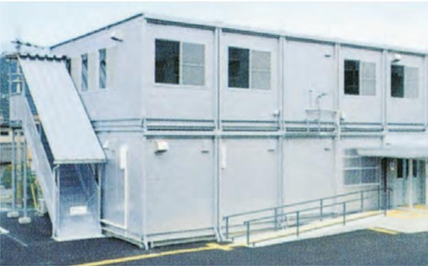
完全工場生産で、建物の内装・照明設備や部材がセットしており、組み立て・解体を繰り返しても廃材が出ず、資源の無駄がありません。現場ではジョイントユニットを使って施工するだけなので、短期間での施工が可能です。また、必要設備をワンタッチで取り付ける、アウターユニットや間仕切りパネルなどのオプションパー
